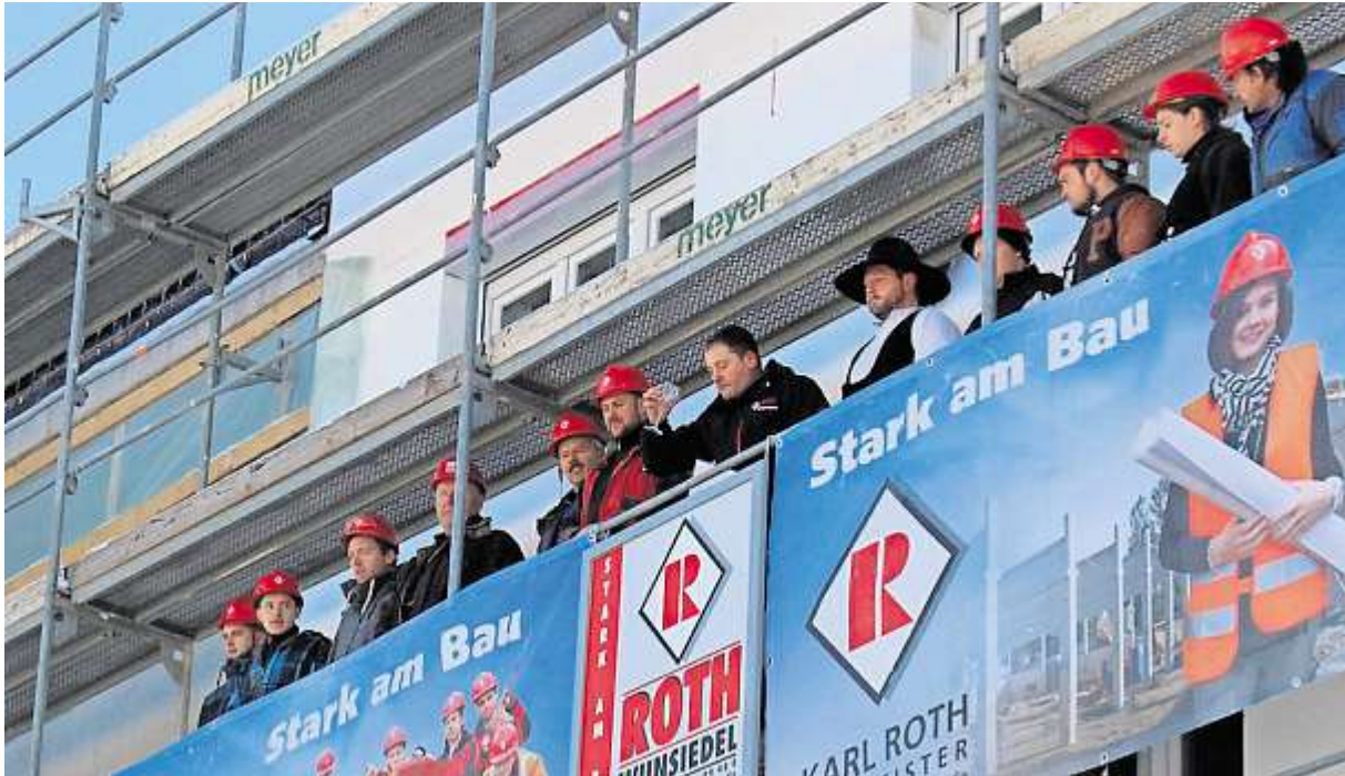
Zum Richtfest postierten sich die Handwerker hoch oben auf dem Gerüst.
