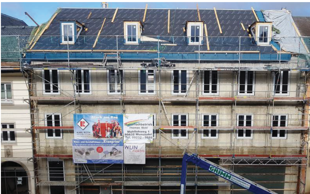
Struktur und Funktionalitäten sind am Rohbau klar erkennbar.
